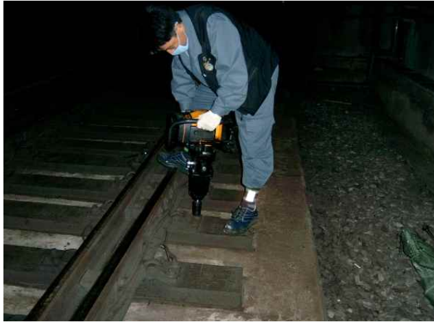
그림 9. 임팩터를 이용한 나사 풀고 박기.
