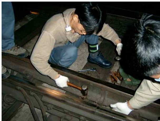
그림 10. 레일침목에 있는 나사에 망치질을 하는 모습.
